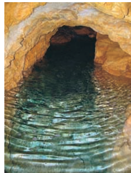
Galería o mina de agua, un tipo de captación muy abundante por toda la geografía andaluza, que termina generando realmente una fuente o un manantial antrópico. (C. Herrera).
